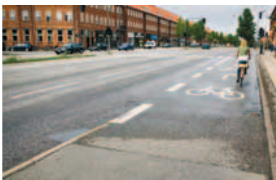
Billede 2.9: Afkortet cykelsti, som etableres ved at cykelstien eller -banen afbrydes i nogen afstand fra stoplinjen, hvilket vil muliggøre fletning mellem cyklister og højresvingende bilister i et kørspar afmærket med højresvingspil
